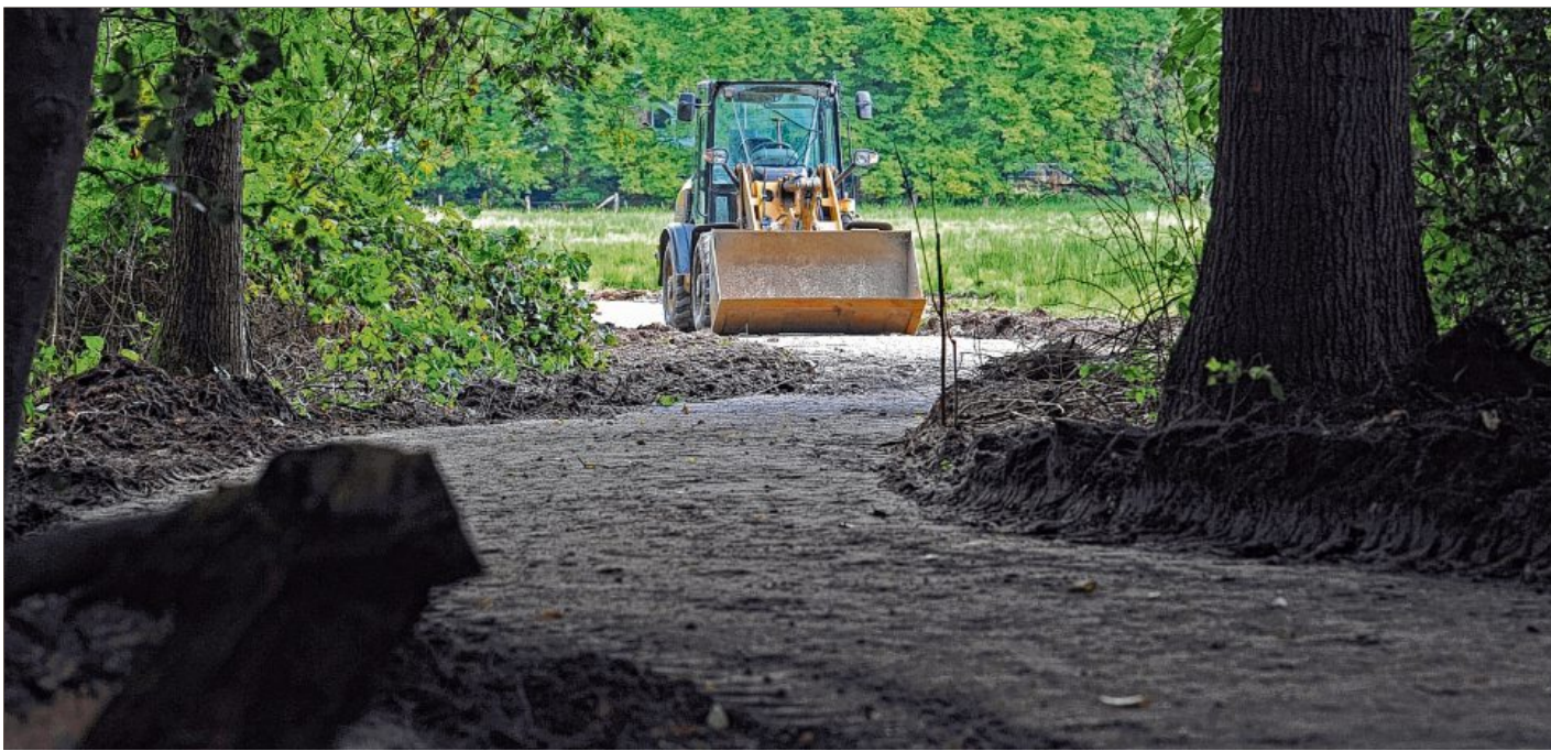
Die Bagger sind da: Am Rand des Philippsburger Parks entsteht ein rund 200 Meter langer neuer Weg. BILD: ORTGIES
